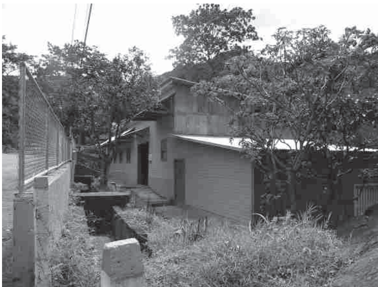
Fig. 5: Edificio donde se ubicó la planta embotelladora de agua mineral Las Piedras (1955 – 1963) en Salitral de Santa Ana.
